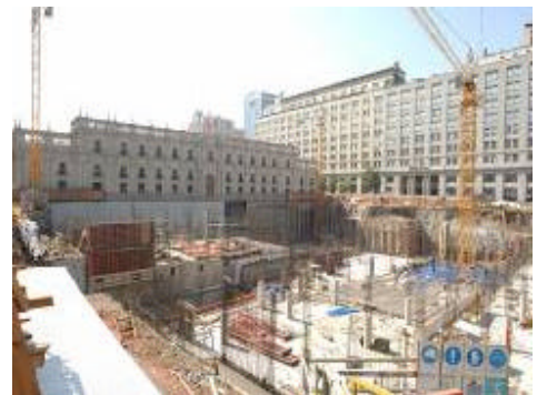
Excavación frente a la Casa de Gobierno para la construcción de nuevos espacios monumentales por parte del Estado. PLAZA DE LA CIUDADANIA. MOPITT. 2004
